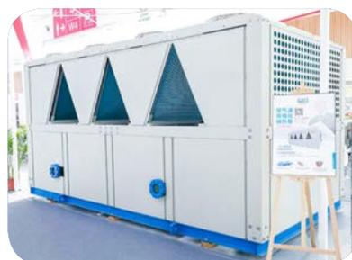
瀚艺风冷低温双级压缩螺杆机组
